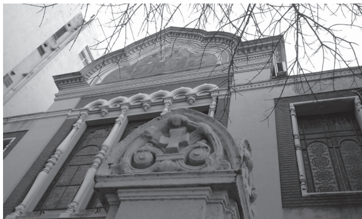
Vista del remate de uno de los pilares de la verja y, atrás, el mosaico de la Santísima Trinidad sobre el tímpano, en el frontón mixtilíneo (Foto OADM, 2021)
